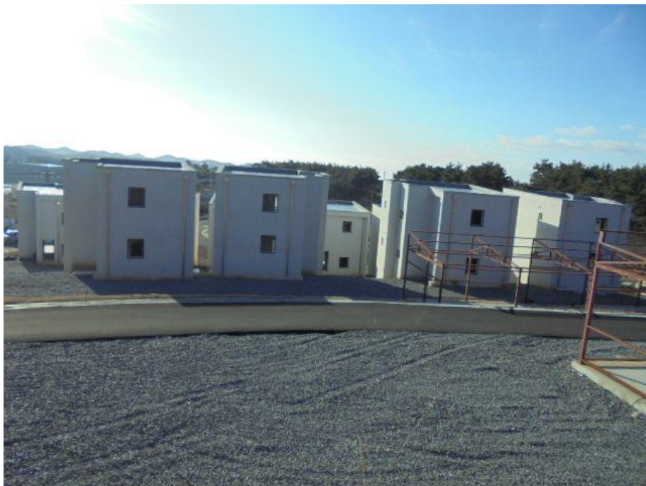
본건 신축중인 건물 및 골조
