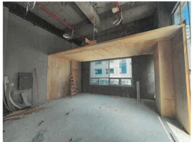
일련번호(6) 내부 전경
