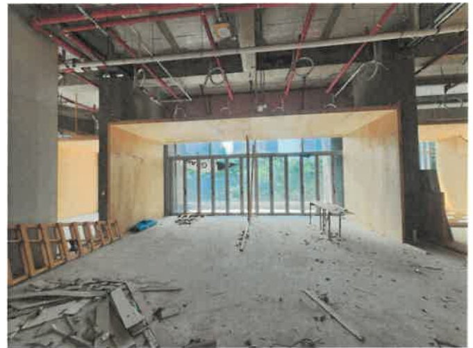
일련번호(4) 내부 전경
