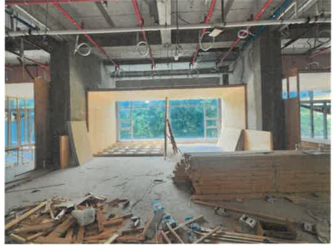
일련번호(3) 내부 전경
