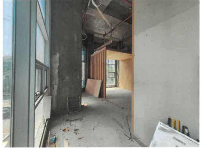
일련번호(5) 내부 전경
