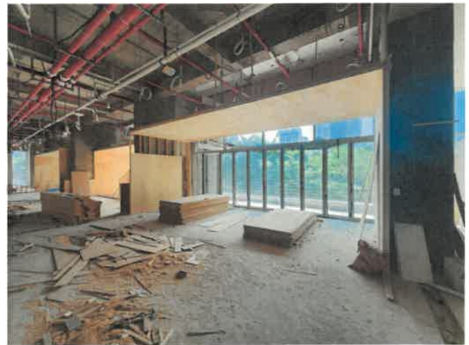
일련번호(2) 내부 전경
