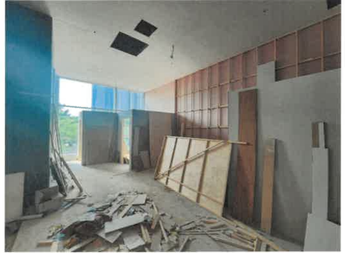
일련번호(1) 내부 전경
